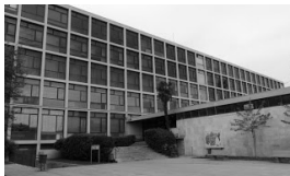
Edificio de Estudios Mercantiles, Barcelona
